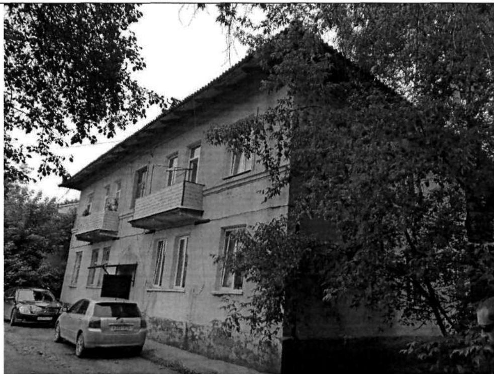
Фото 1. Обзорное фото. Объект обследования – здание по ул. Кашика, д. 47.
